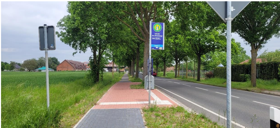
Abb. 7: Blick Richtung Norden. Nordstraße mit Bushaltestelle „Am Ahrenberge“. Links das Plangebiet. (pz 2023)
