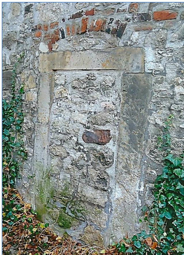
Ehemaliger Zugang zur Kirche
