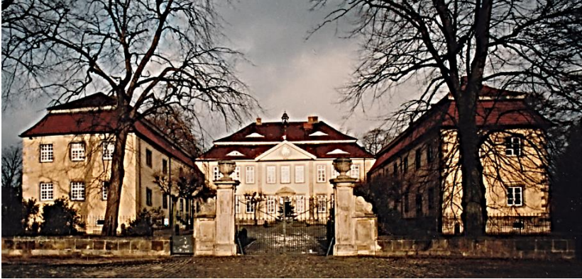
Das Schloss während der Renovierung
