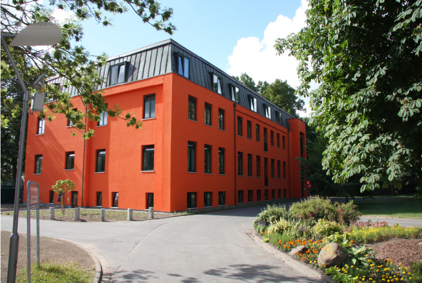
Modernisiertes Haus im Wollschlägersweg in Köthenwald
